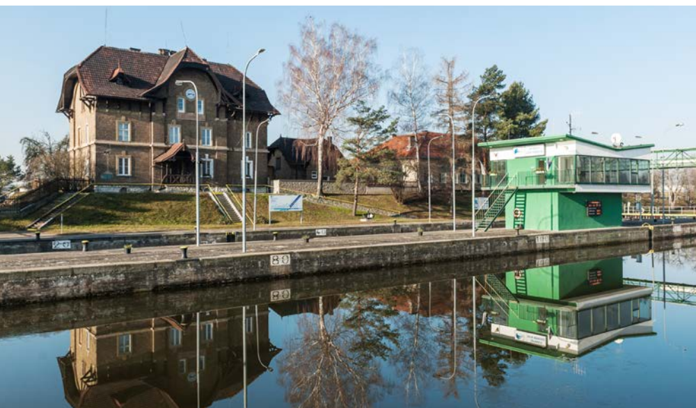
Plavební komory Dolní Bejkovice na labské vodní cestě
